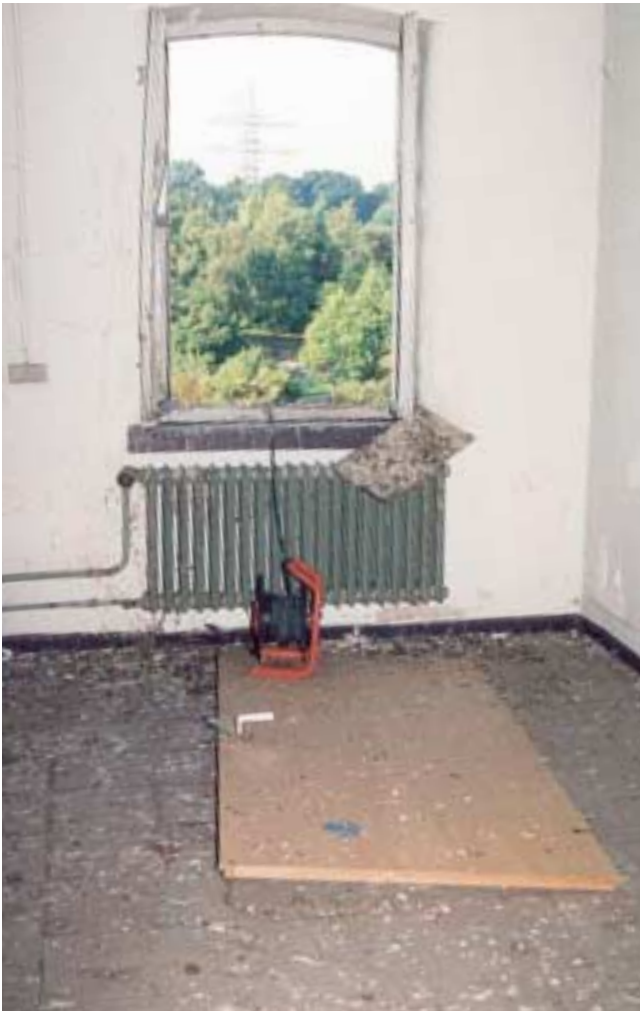
Abb. 3a, b: Taubenkotkontamination, die gut absaugbar ist
